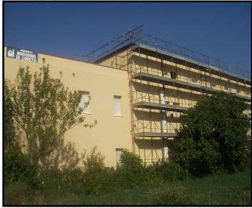
I lavori del Priorato stanno finalmente volgendo al termine. Tutte le pareti sono state rivestite da un termocappotto, il tetto è stato isolato e ricoperto da pannelli fotovoltaici, in grado di soddisfare ai bisogni di elettricità della casa e della cappella per i prossimi 25 anni.
